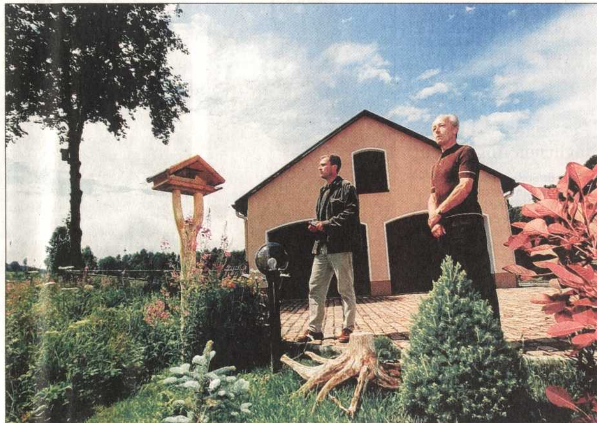
Ausblick in eine düstere Zukunft. Die Jöhstädter Bauherren verlieren jetzt – Garage und Abrisskosten zusammen – 80.000 Mark.
